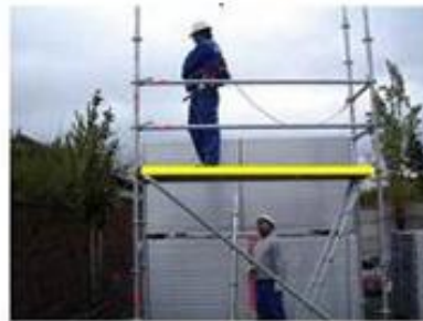
9 Colocación de rodapié alrededor del andamio
