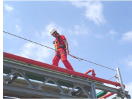
Correcto uso del equipo de protección contra caídas
