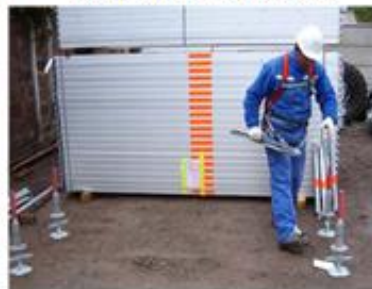
1 Colocación de bases
