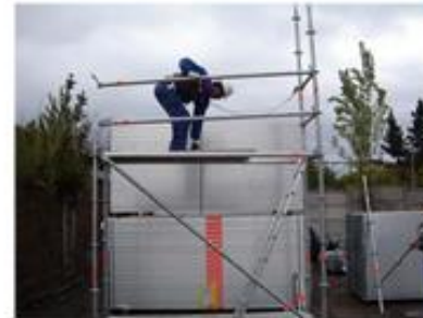
9 Colocación de rodapié alrededor del andamio
