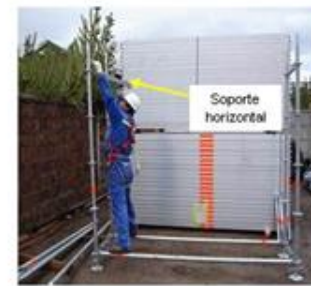
6 Retire las piezas del soporte horizontal
