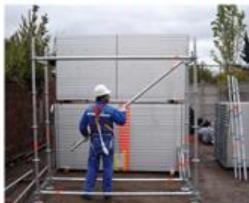
5 Colocación de crucetas
