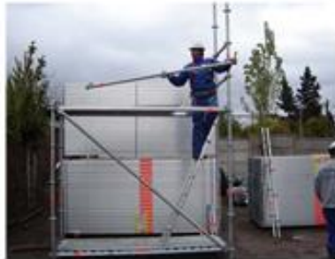
9 Colocación de rodapié alrededor del andamio
