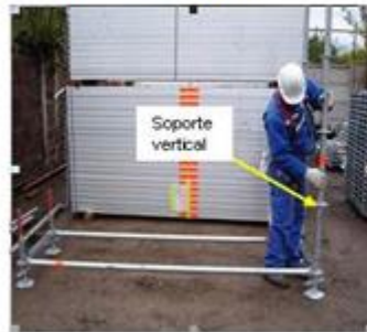
7 Retire los soportes verticales
