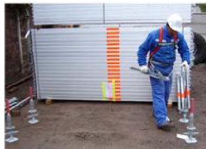
9 Retire las bases y limpie el área
