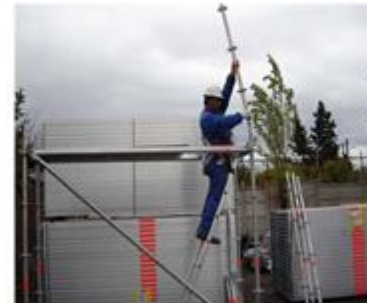
6 Retire las piezas del soporte horizontal
