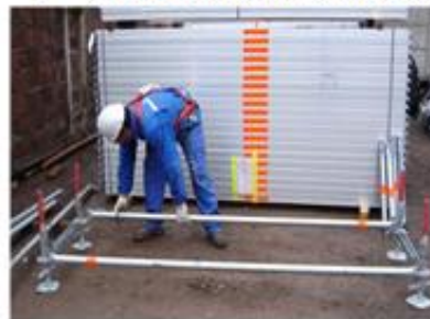
2 Colocación de marco inferior
