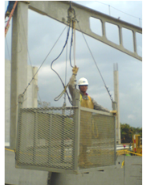
Izaje de canasta con grúa
