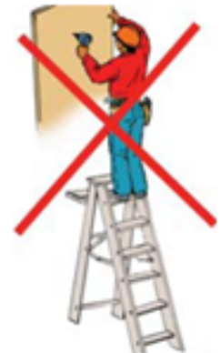
Forma incorrecta de usar escaleras tipo “A”
