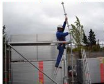
6 Colocación de plataforma y soportes verticales
