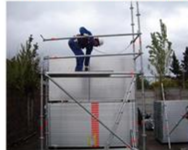
4 Retire plataformas y soportes verticales
