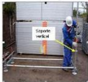
3 Colocación de soportes verticales
