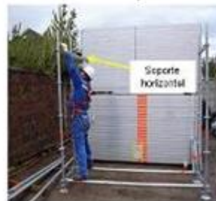
4 Colocación de soportes horizontales
